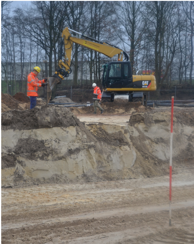
Fig. 17: Kanaalpark Rosmalense Aa, de locatie van de derde proefsleuf in deelgebied D, op de achtergrond wordt sleuf 11 aangelegd. De jalon geeft het midden van de sleuf aan.
