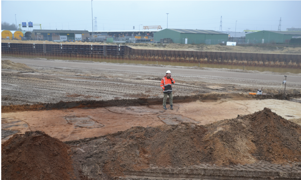
Fig. 16: Kanaalpark Rosmalense Aahet vlak van proefsleuf 11, deelgebied D. De bovengrond is verwijderd in verband met OCE-onderzoek
